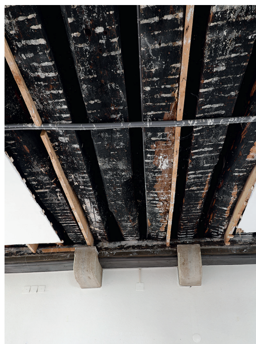
5 Aarwangen, Schloss. Enggestellte Bodenbalkenlage (Herbst/Winter 1372/73d) des mutmasslichen Obergadens. Blick nach Süden.
